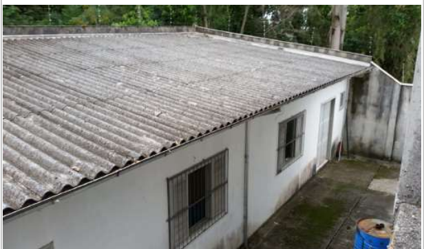
VISTA FACHADA - CONSTRUÇÃO FUNDOS
