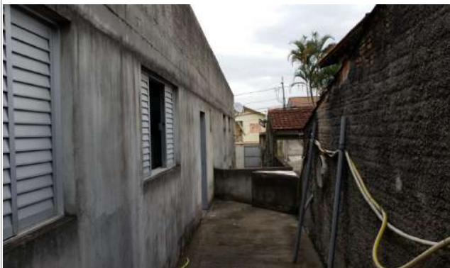
VISTA LATERAL ESQUERDA - SALA COMERCIAL
