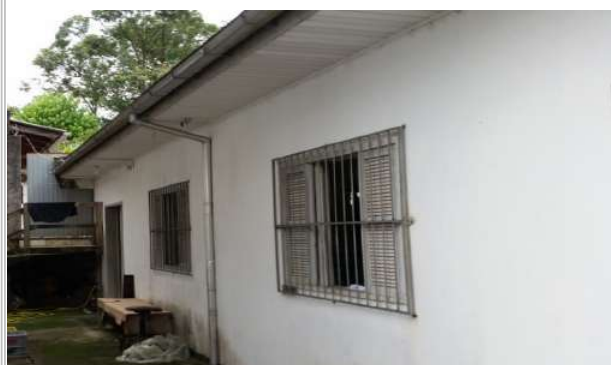
VISTA FACHADA - CONSTRUÇÃO FUNDOS
