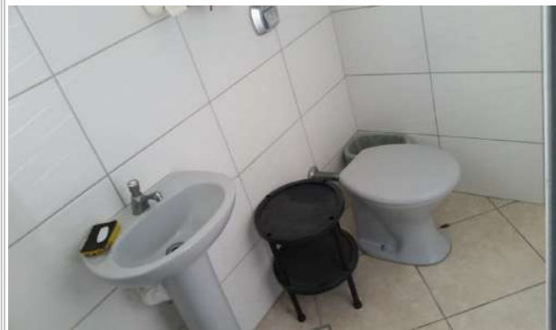
VISTA BANHEIRO 02 - SALA COMERCIAL
