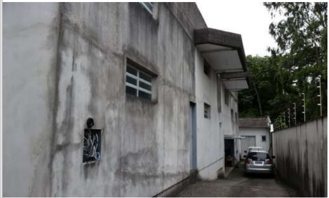
VISTA LATERAL DIREITA - SALA COMERCIAL
