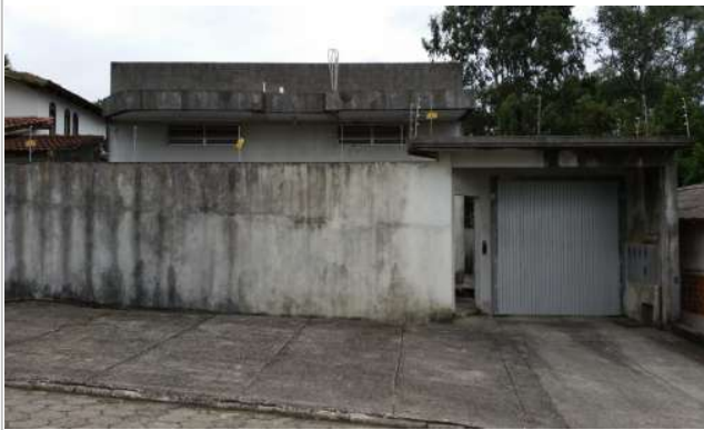
VISTA DA FACHADA - SALA COMERCIAL
