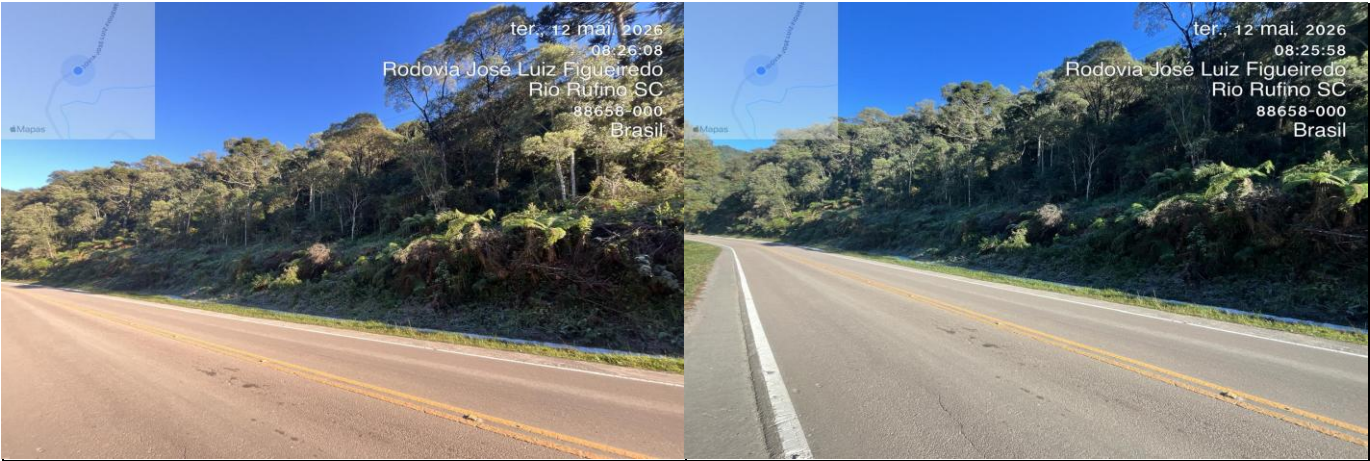
Vista do imóvel as margens da Rodovia Estadual SC112
