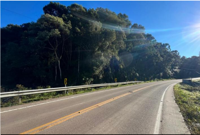
Vista do imóvel as margens da Rodovia Estadual SC112
