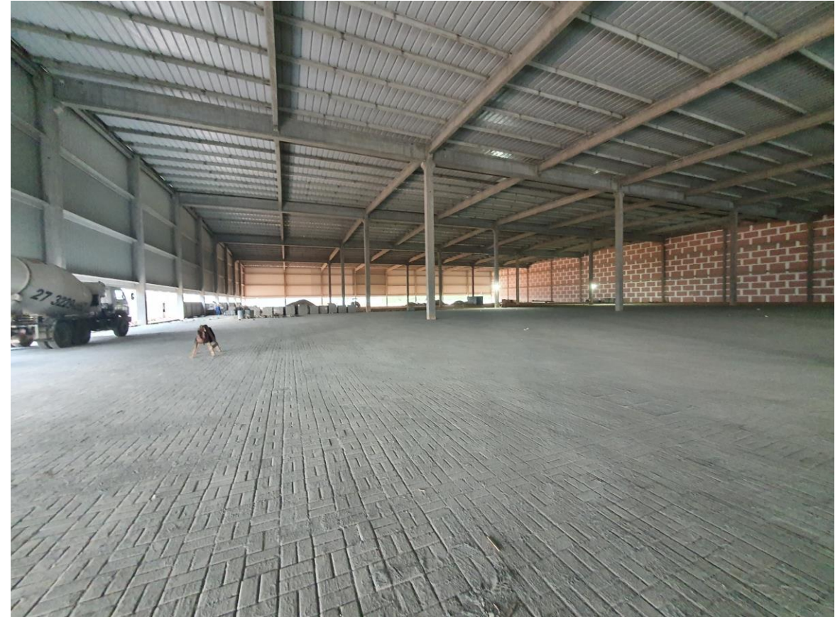
Piso em blocos de concreto com cross-docking
