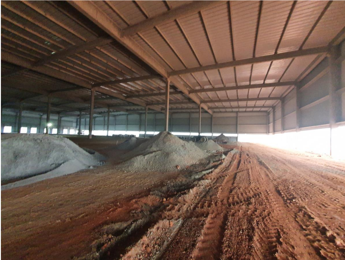
Piso super compactado e obras aceleradas
