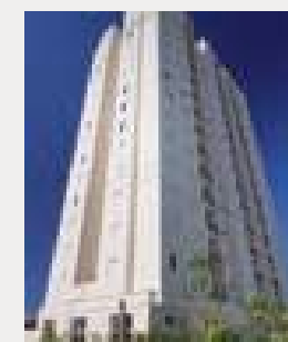
Edifício Felice Vila Formosa
