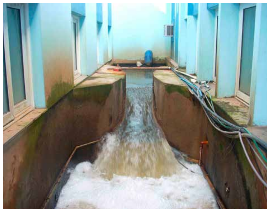
Entrada de água bruta na Estação de Tratamento da Comusa, em Novo Hamburgo
