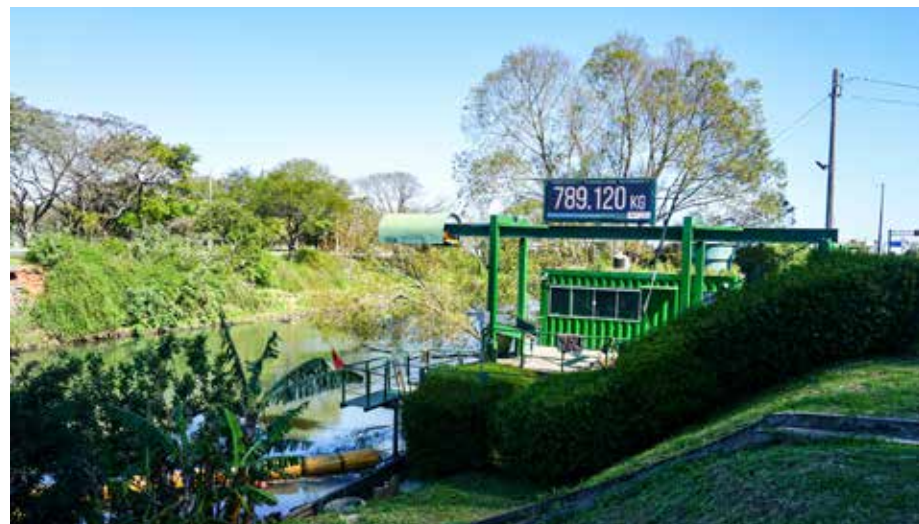
Lixômetro no Arroio Dilúvio mostra quantas toneladas de lixo sólido foram impedidas pela ecobarreira de chegar ao Guaíba em pouco mais de cinco anos de implantação
